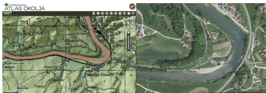
Slika 2-3: Odsek Savinje na območju Natura 2000 Savinja – Celje Zidani Most (SI3000376), kjer potekajo intenzivne regulacije, ki so uničujoče za vodni živelj. Bližnji kraj Marija Gradec, Laško. Vir: Atlas okolja.
